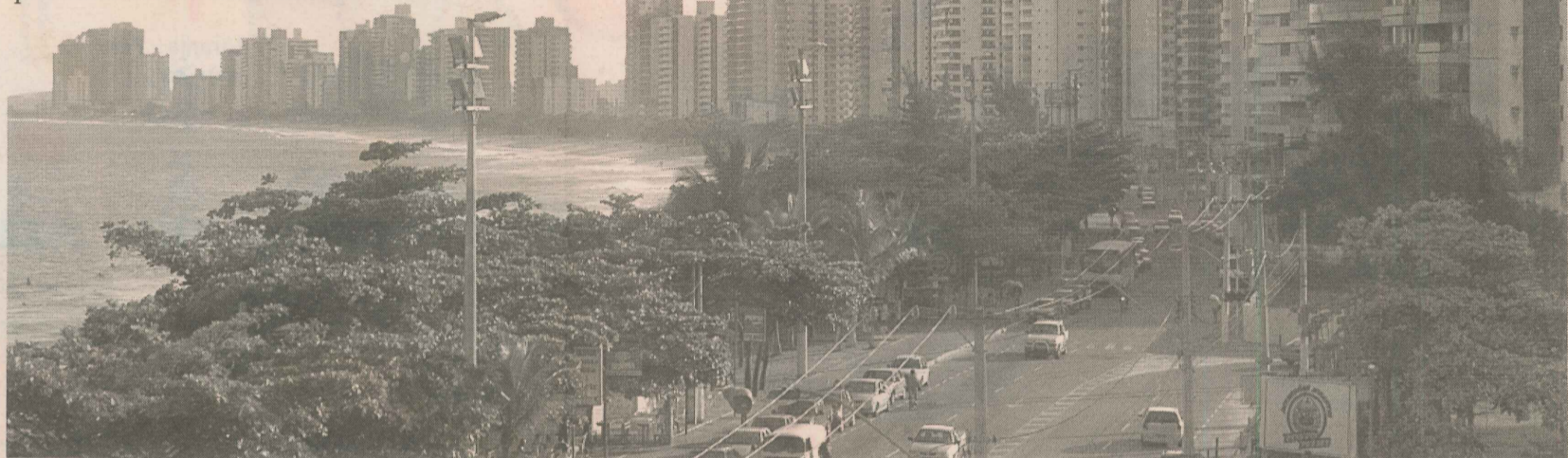
Praia de Itaparica, que deverá receber novas obras de urbanização, com investimento previsto de R$ 20 milhões
