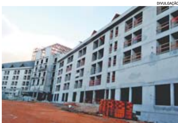
OBRAS DO HOTEL BRISTOL VISTA AZUL, em Pedra Azul, Domingos Martins: 104 suítes hoteleiras e 125 unidades residenciais
