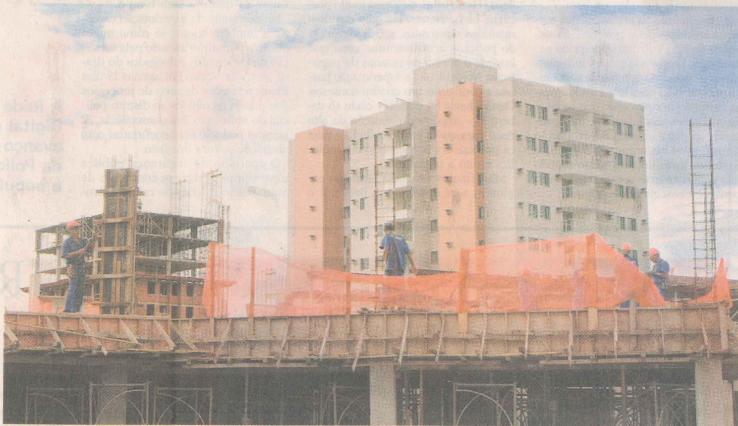
O PREFERIDO DAS CONSTRUTORAS. Em Jardim Camburi, no ano passado, foram aprovados 2.003 projetos para a construção de novas unidades residenciais. FOTO: CARLOS ALBERTO DA SILVA
