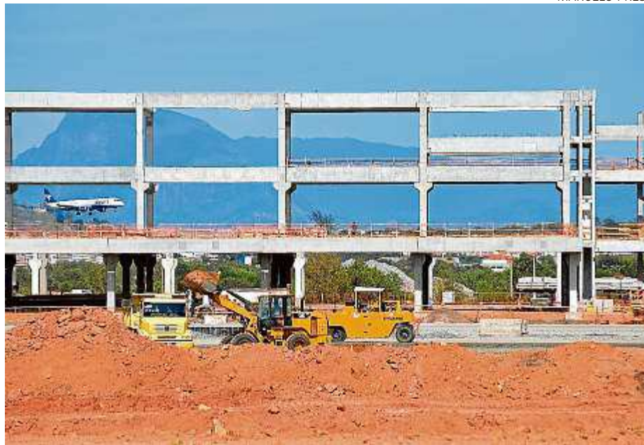
Obras no Aeroporto de Vitória: novo terminal pode aumentar a competitividade do ES
