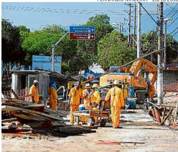
Homens trabalhando na obra da avenida em Vitória
