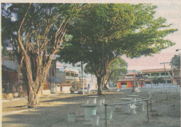
EM SANTA MÔNICA, a praça Haroldo Rosa está com o piso quebrado e as árvores escurecem o local.
