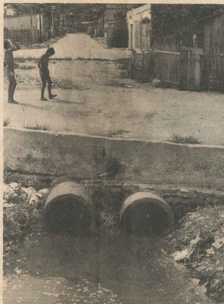
Os esgotos são lançados a céu aberto
