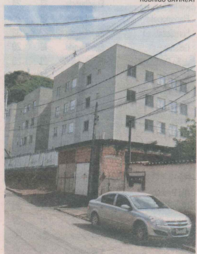
CONDOMÍNIO em construção
