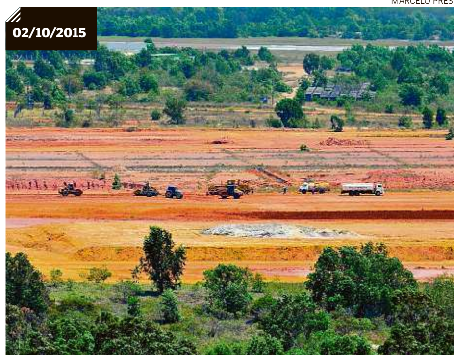
Após 100 dias, pouco foi feito no local. Máquinas ainda realizam a terraplanagem
