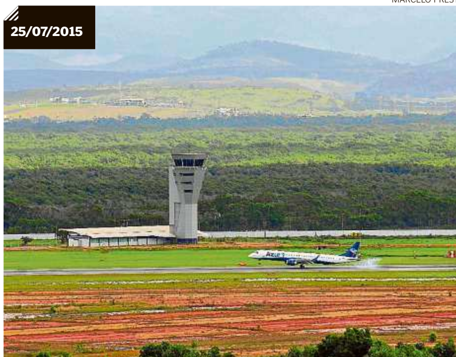
Em julho, um mês após a ordem de serviço, obra na nova pista não tinha começado
