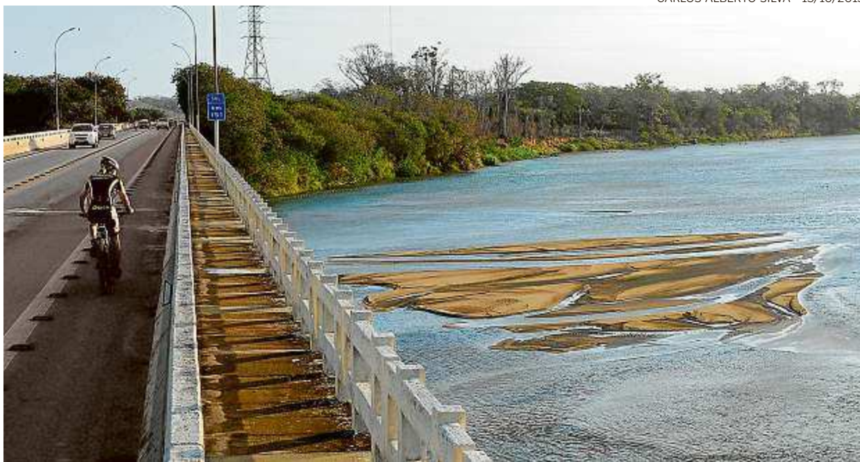
Rio Doce, em Linhares: prefeitura está ligando tubos na altura da sede até a central no bairro Colina
