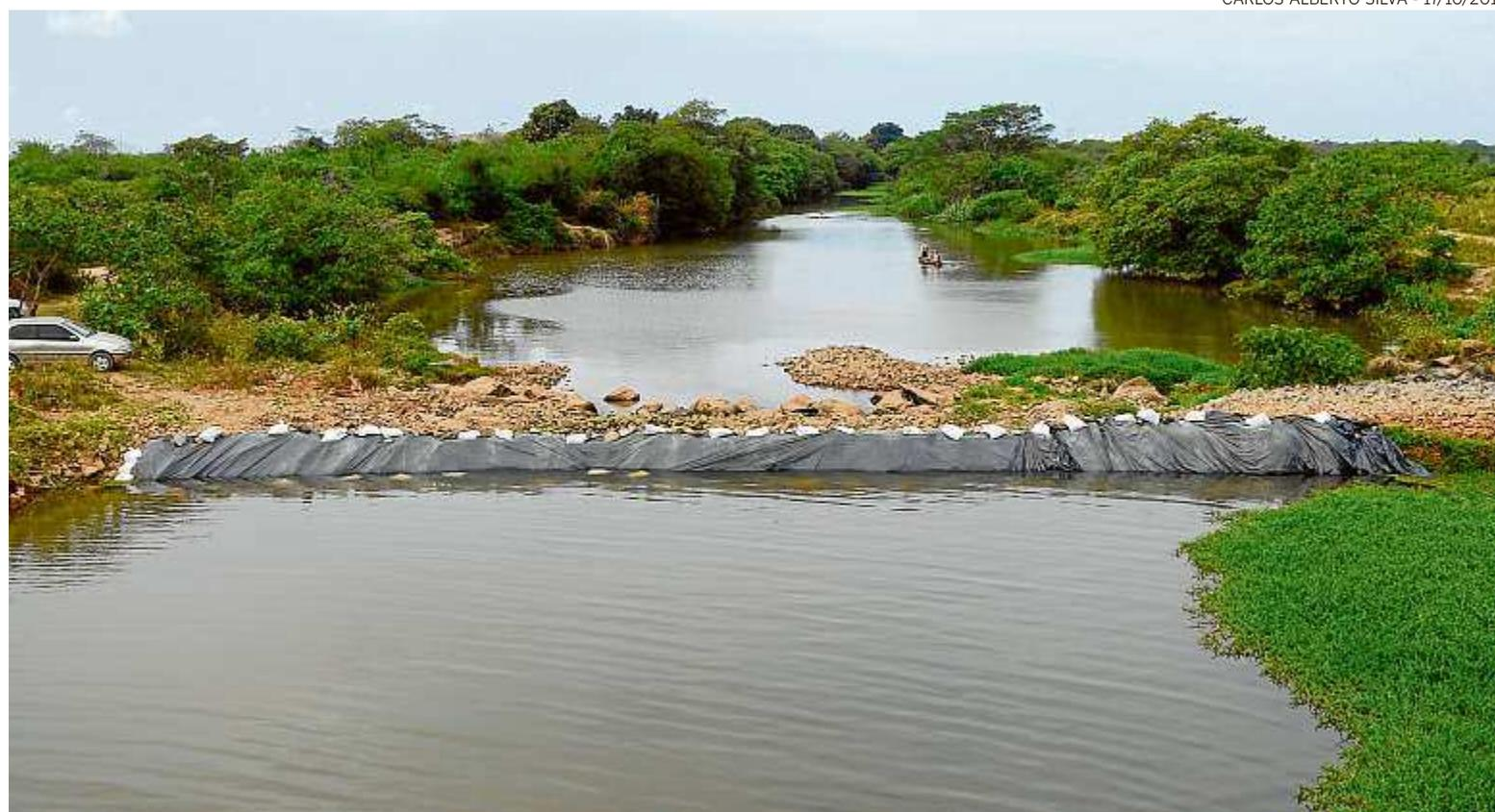
No último dia 17, o nível de água do Rio Jucu estava baixo, e a Cesan colocou plástico na barreira para reter a água que lá passava
