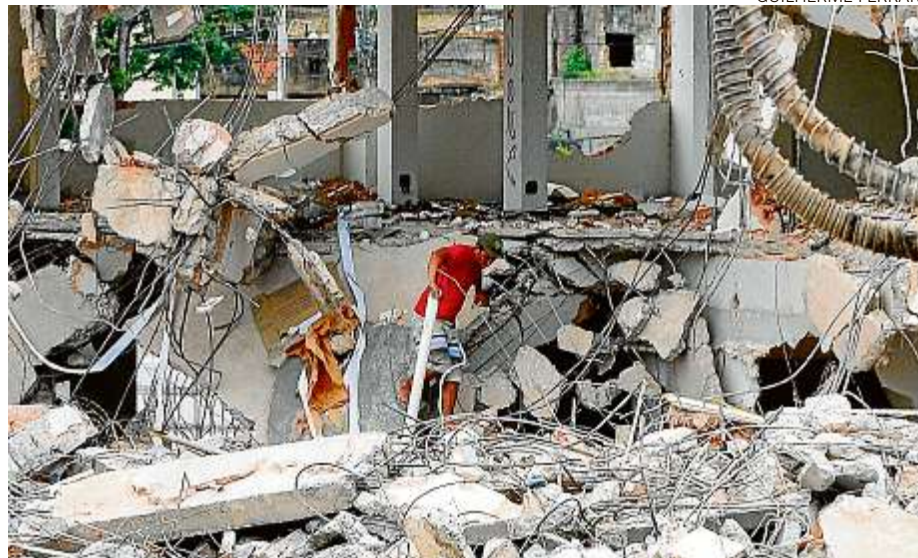
Prédios na região do Centro estão sendo demolidos para construção da via
