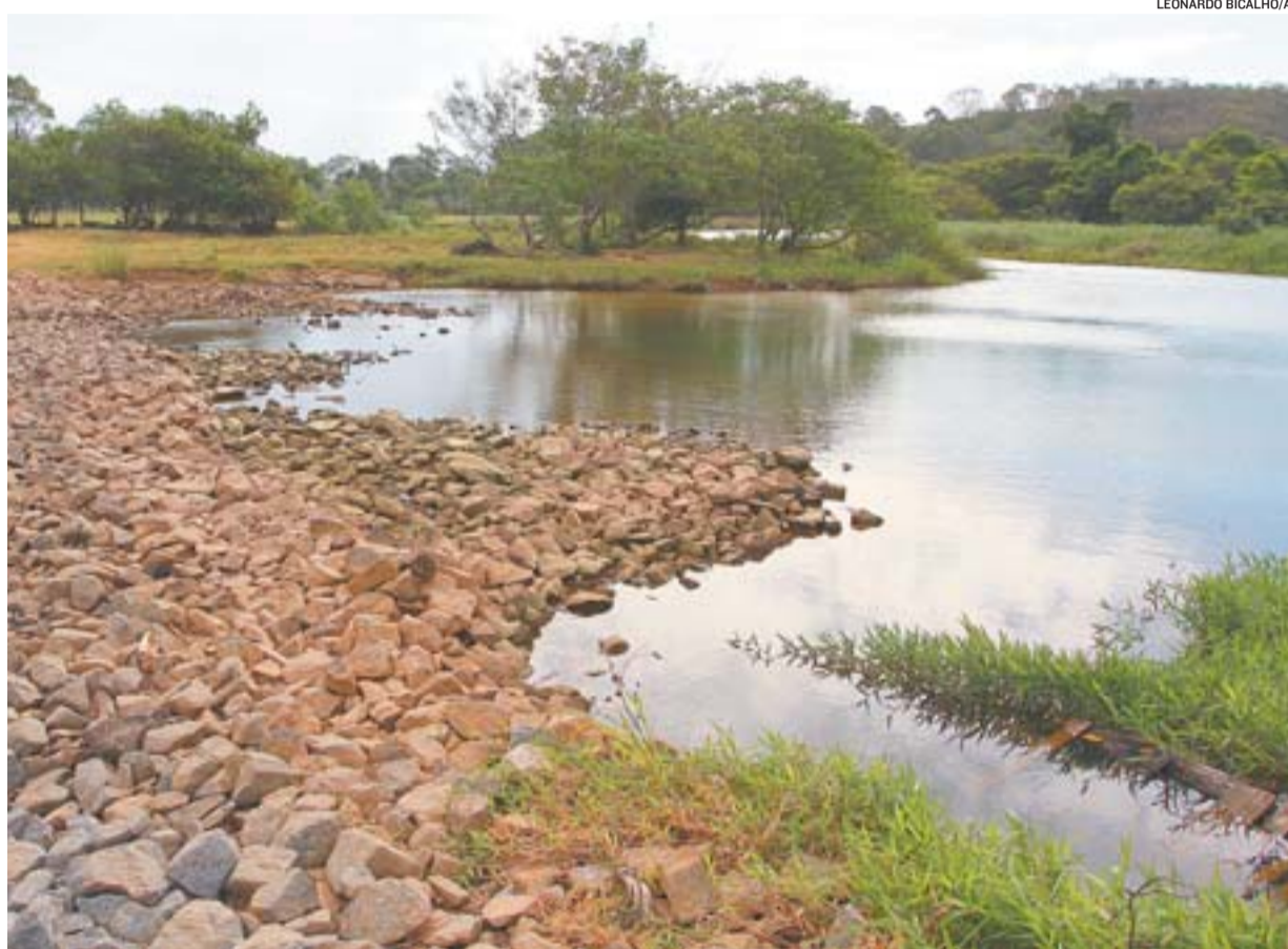
RIO SANTA MARIA em Queimados, na Serra, onde é feita a captação de água para abastecimento na Grande Vitória
