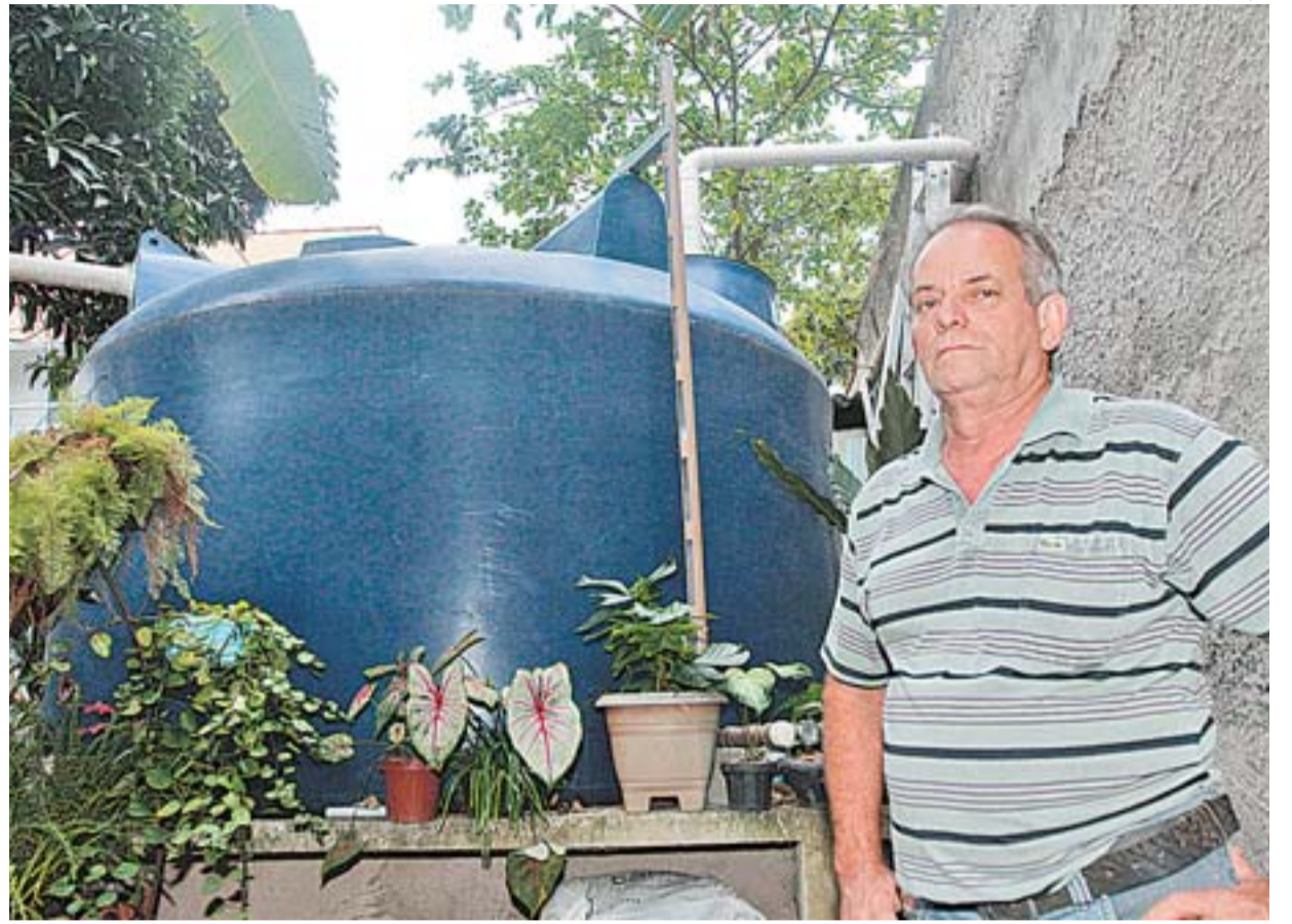
LUIZ CARLOS instalou uma caixa que comporta 20 mil litros de água em sua casa para captar água da chuva
