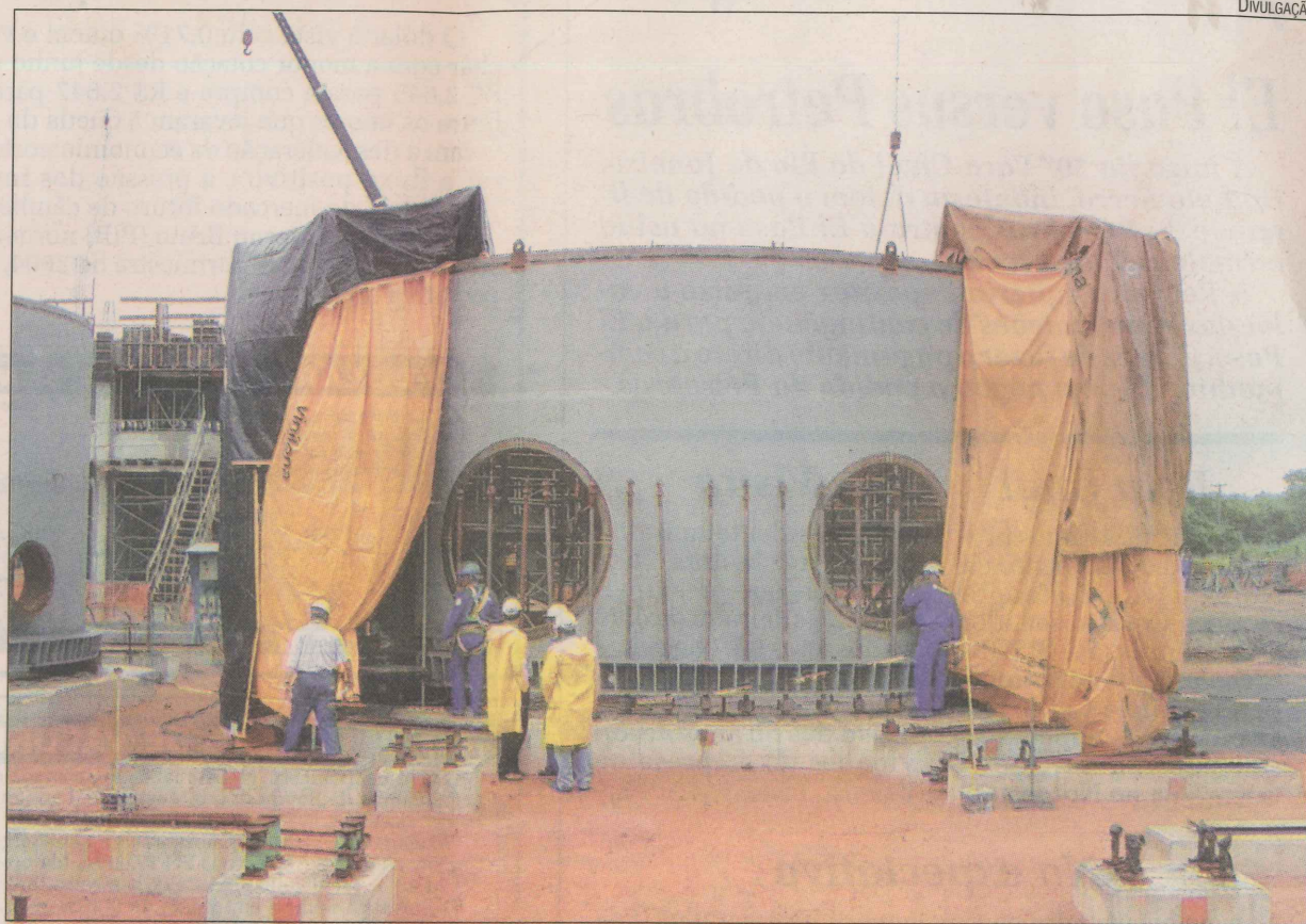
Representantes dos consórcios inauguraram as obras de montagem do alto-forno na CST
