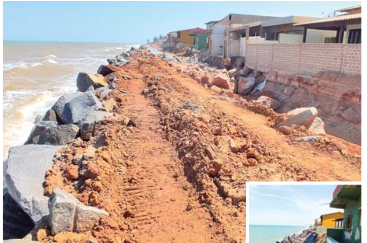
PEDRAS e terra foram colocadas na área destruída pela erosão (destaque)
