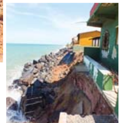
PEDRAS e terra foram colocadas na área destruída pela erosão (destaque)
