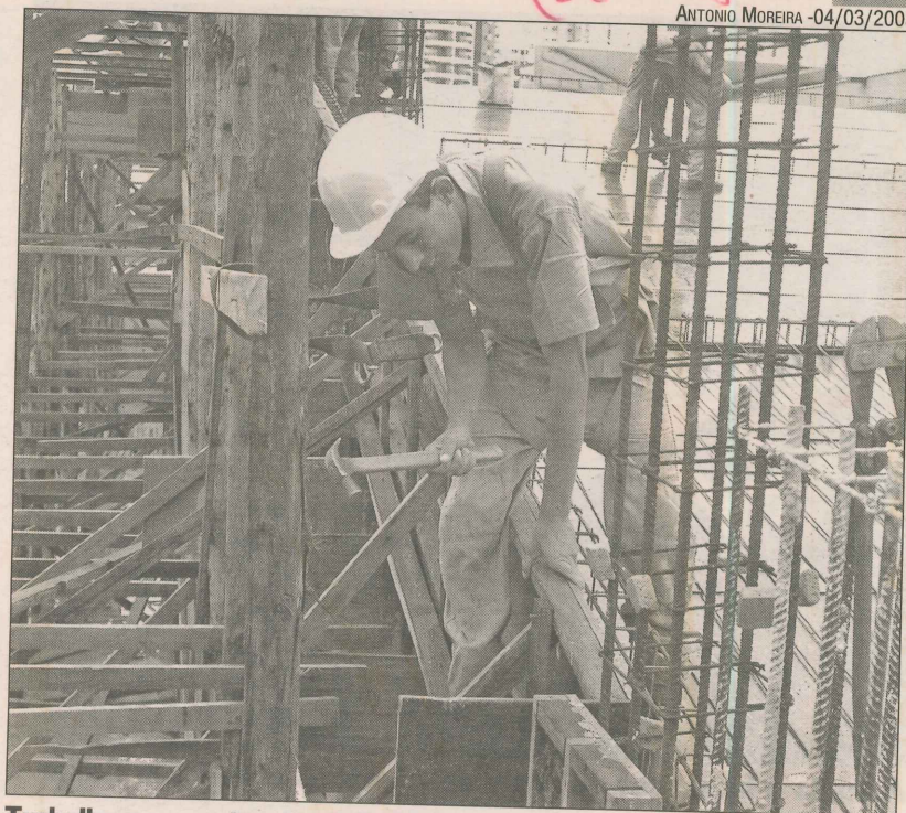
Trabalho na construção civil: liderança em empregos com carteira
