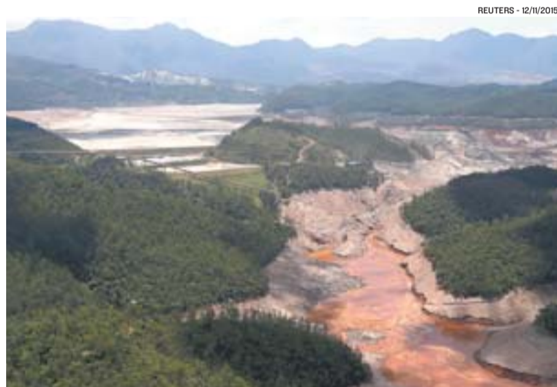
BARRAGEM da Samarco: governo de Minas investiga uso pela Vale
