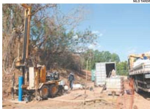
POÇOS ARTESIANOS ainda estão sendo perfurados em Colatina por uma empresa contratada pela Samarco
