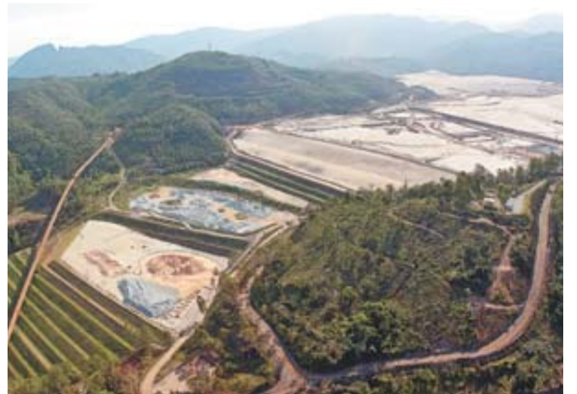
BARRAGEM DE GERMANO tem risco de rompimento, segundo relatório
