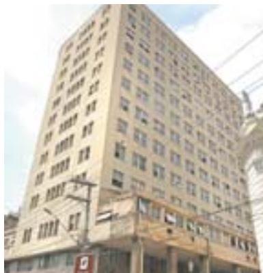
EDIFÍCIO: reclamação de abandono
