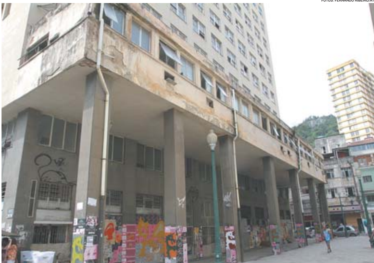
EDIFÍCIO PRESIDENTE VARGAS , em frente à Praça Costa Pereira, está sem utilização há mais de três anos
