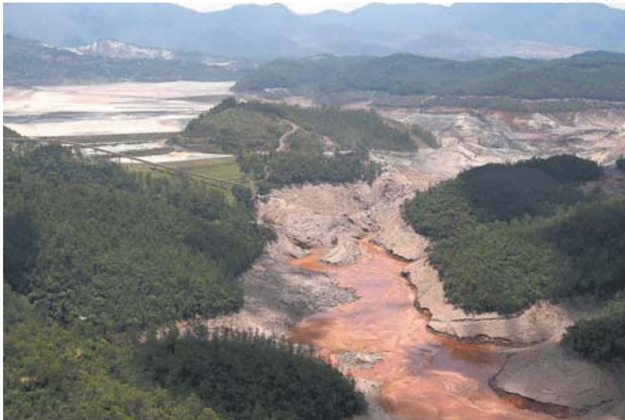
COMPLEXO DE GERMANO, em Mariana (MG), onde ficava a barragem de Fundão, da Samarco, que rompeu
