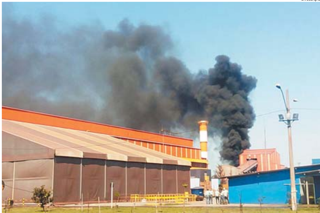
NA HORA DA EXPLOSÃO, saída dos fundos da área da caldeira estava trancada, segundo apontou o relatório
