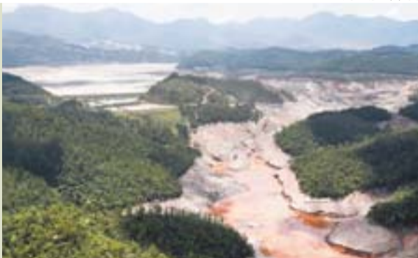
BARRAGEM DE FUNDÃO: união de reservatórios
