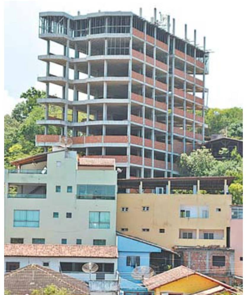
ESTRUTURA foi erguida entre residências: 12º andar estaria em construção
