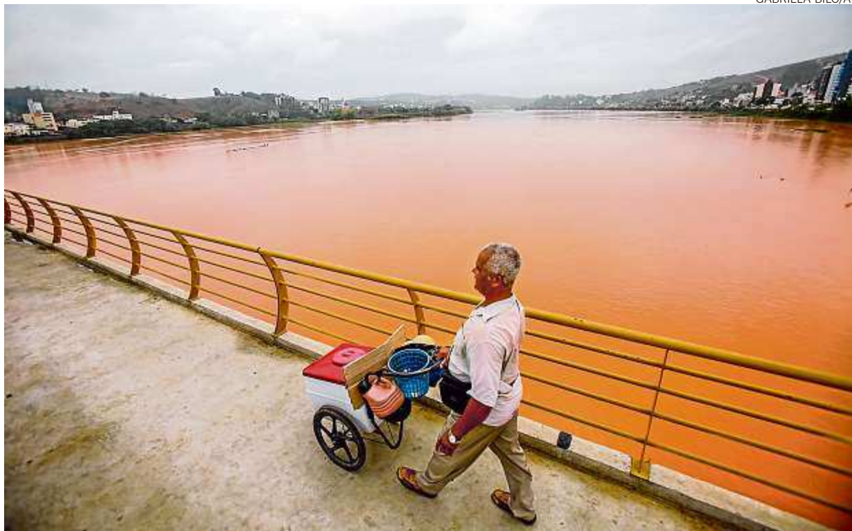
Sob a ponte de Colatina, a água turva pelos rejeitos das barragens assusta os moradores da cidade
