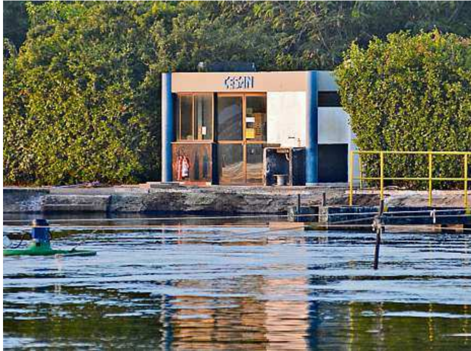
Estação de tratamento de esgoto da Cesan, que planeja atrair mais recursos
