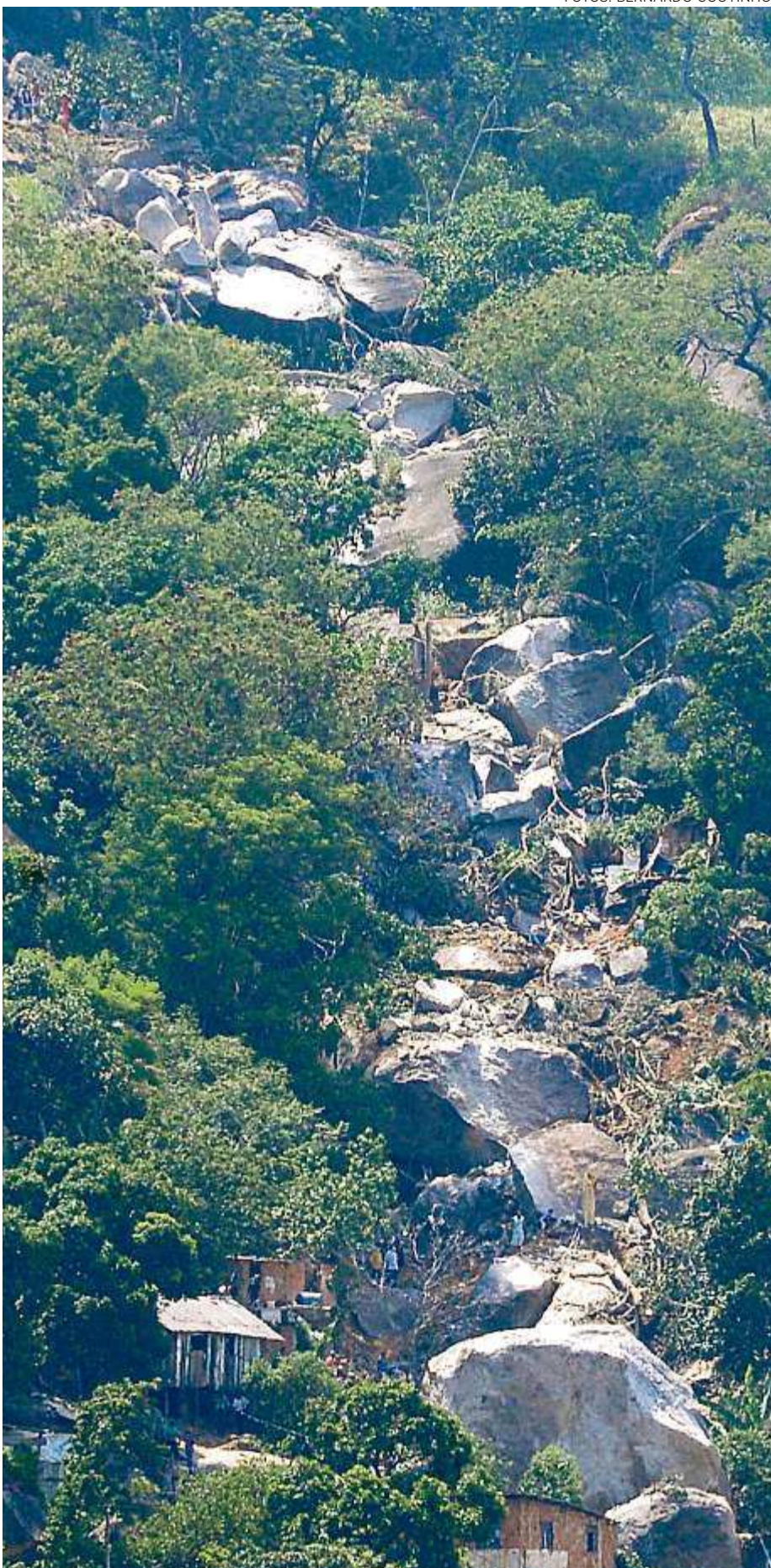
O deslizamento deixou um rastro de destruição de quase 200 metros
