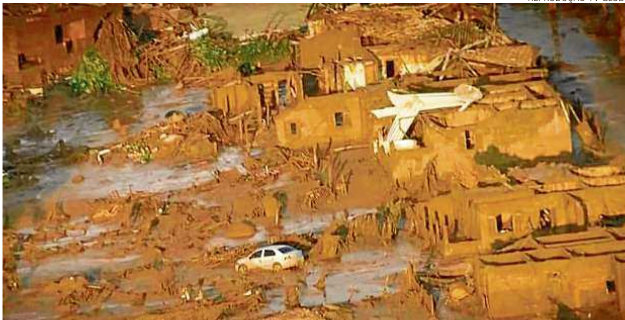
Vista aérea de Bento Rodrigues, em Mariana, mostra como o povoado ficou após o vazamento da lama
