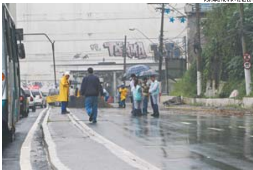
OBRA foi feita na Curva do Saldanha, em 2013, após deslizamento de pedras
