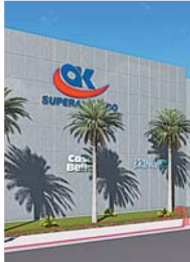
UNIDADE do OK em Vila Velha
