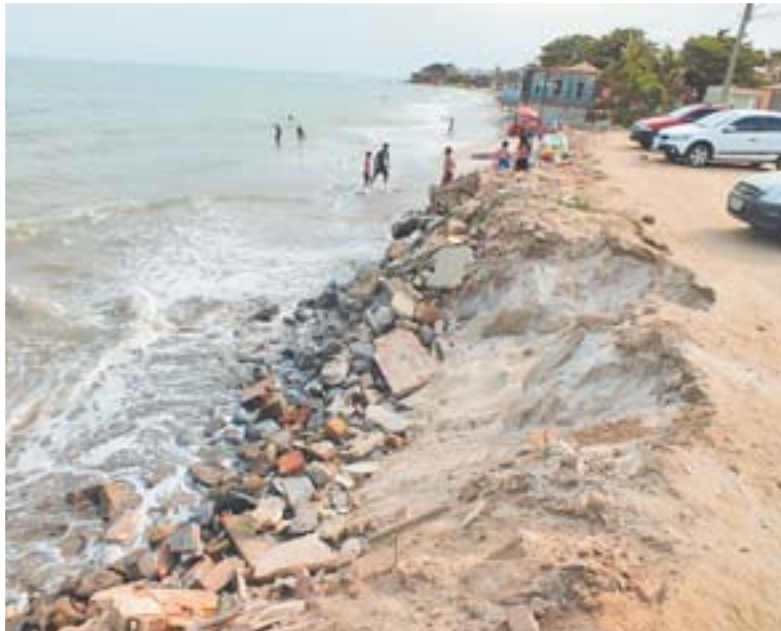
PRAIA DA AREIA PRETA, em Marataízes, onde imóveis foram demolidos
