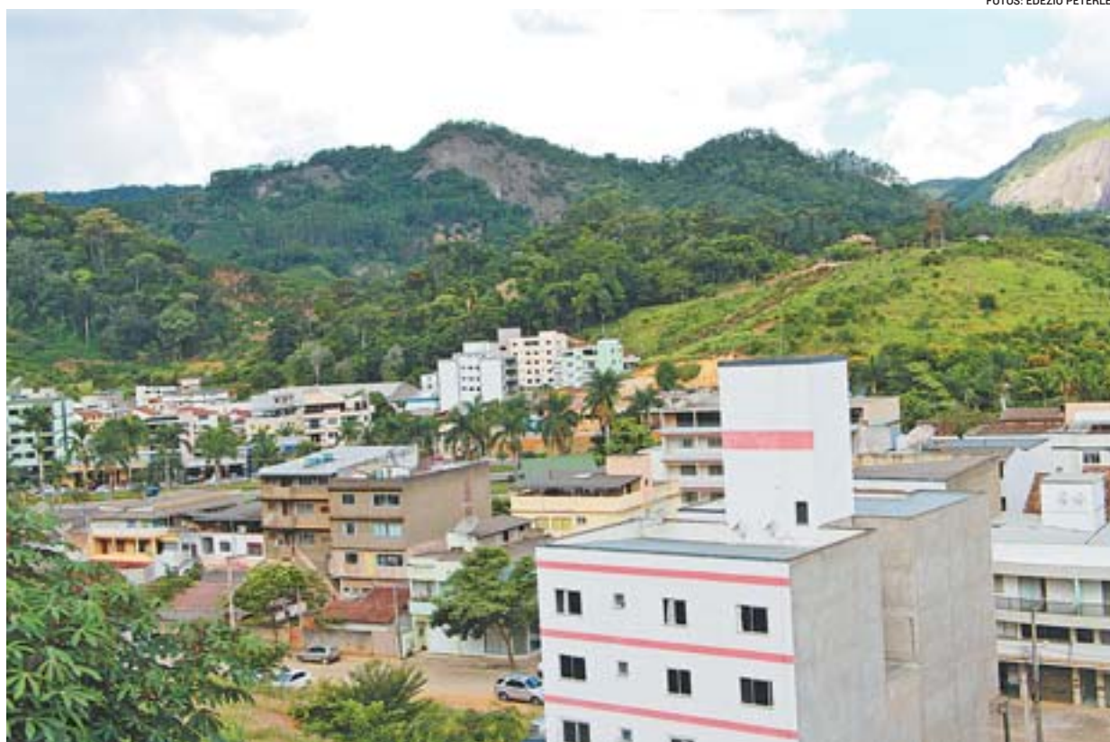
PRÉDIOS EM VENDA NOVA: construções irregulares causam problemas ambientais e de tráfego na cidade
