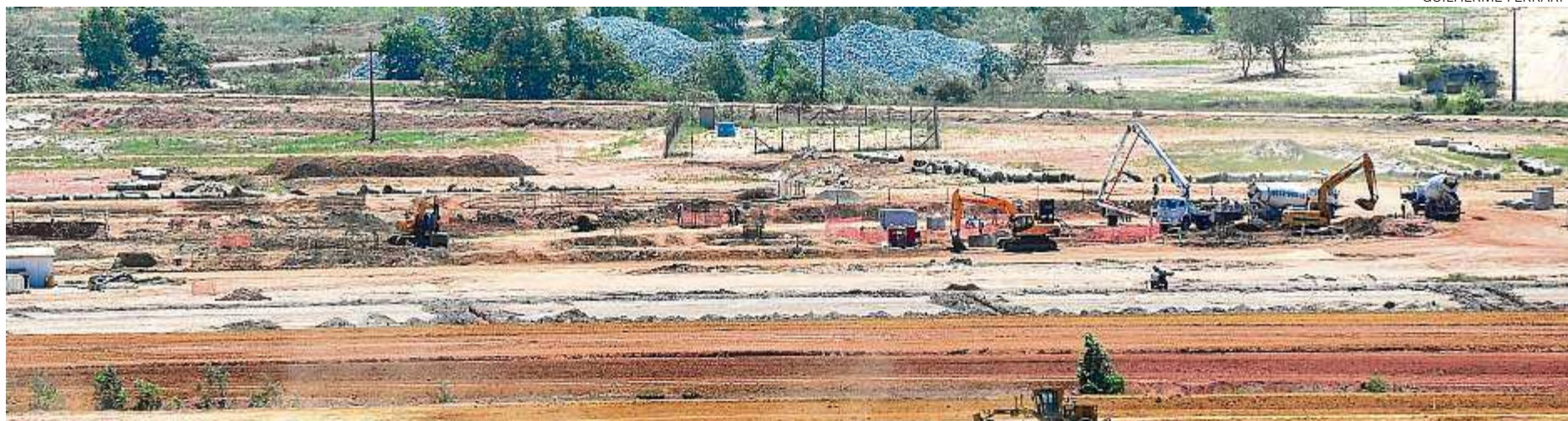
Obras que já estão em andamento no aeroporto contemplam a nova pista de pouso e decolagem, área de onde já foram retirados mais de 200 mil m 3 de terra
