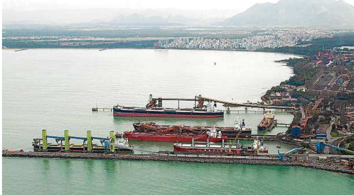
Complexo de Tubarão: vistoria do Iema constatou carvão, minério de ferro e fertilizantes derramados
