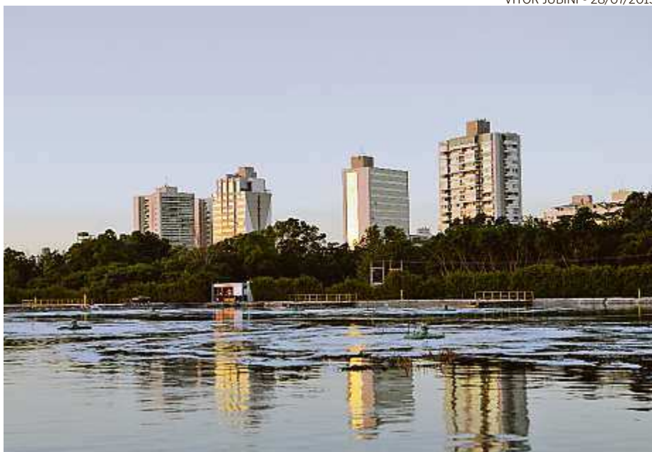
Estação da Cesan: suspeita de esgoto in natura jogado no mar pelas estruturas
