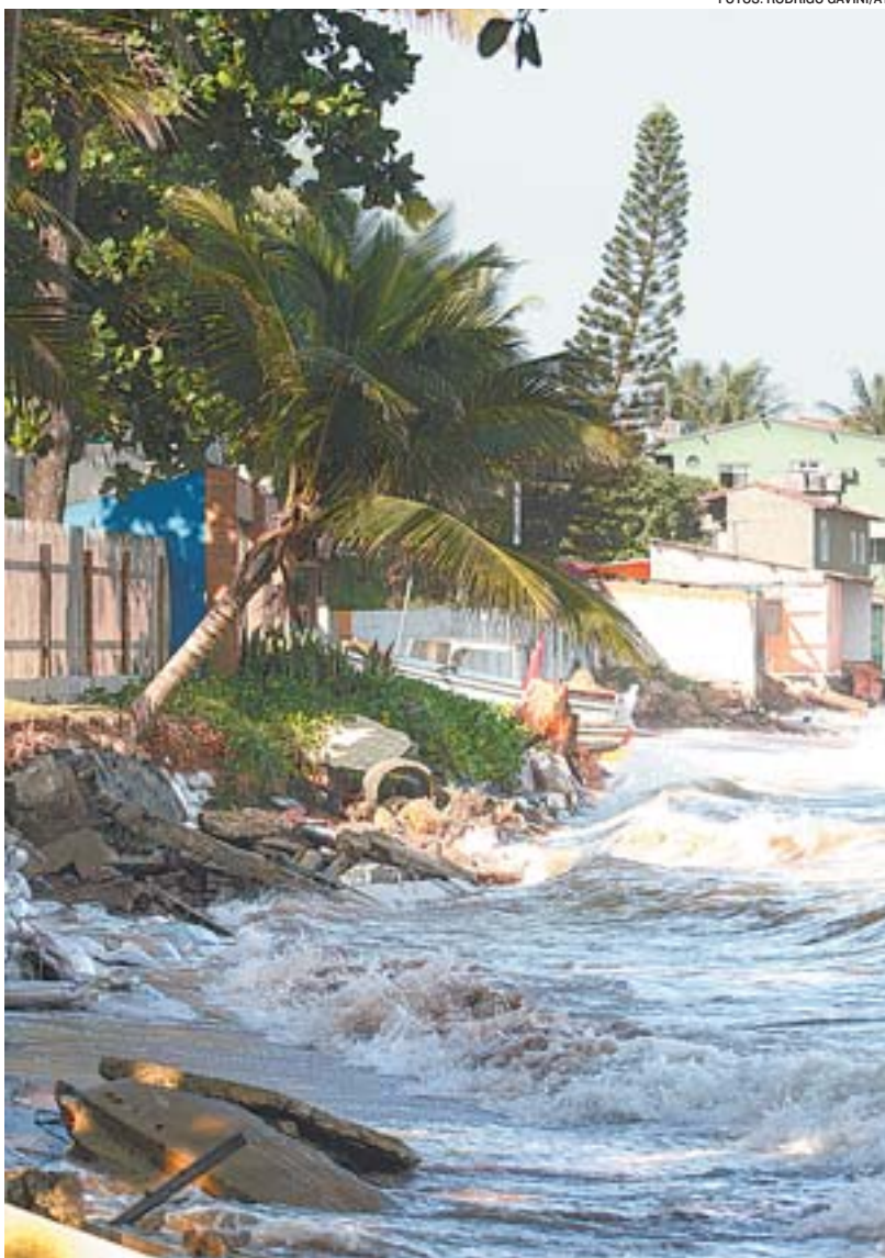
FORÇA DA ÁGUA causou destruição na orla de Ponta da Fruta
