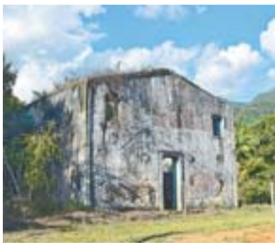
RUÍNAS no distrito de Pedra Menina
