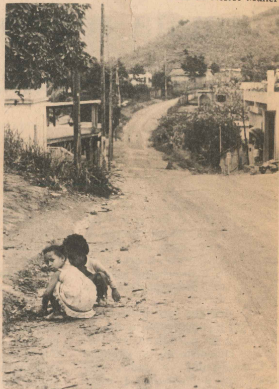
O bairro não tem nenhuma rua calçada
