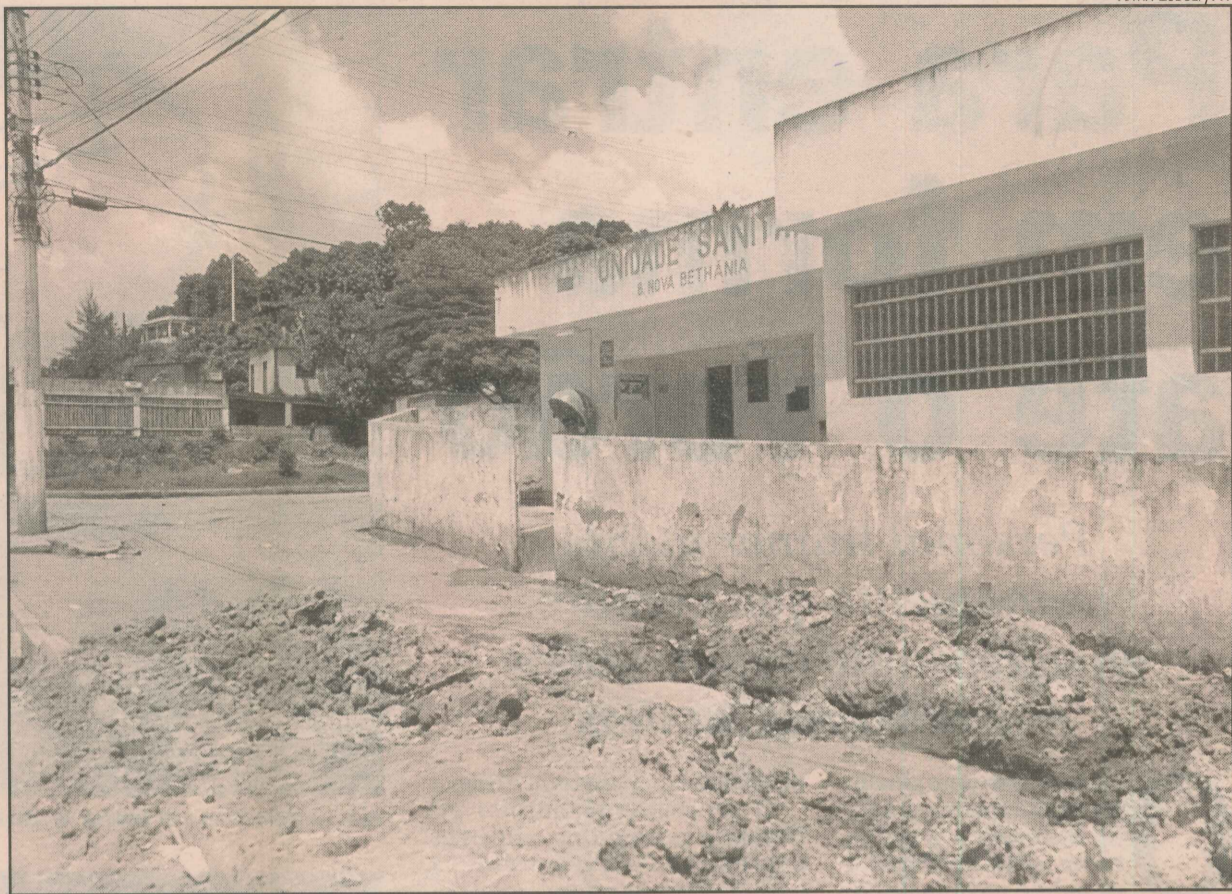
O esgoto a céu aberto tem se transformado em foco de mosquitos, ratos e baratas
