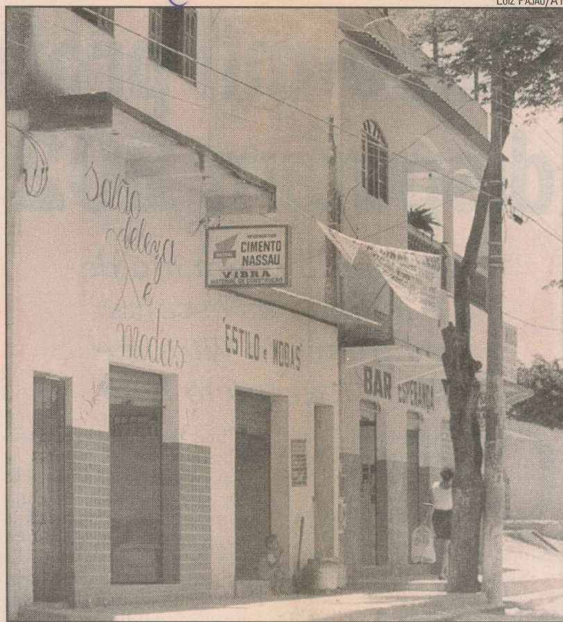
Destaque para mercearias e lojas de material de construção
