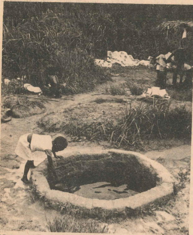
Muitos poços não têm proteção contra a sujeira
