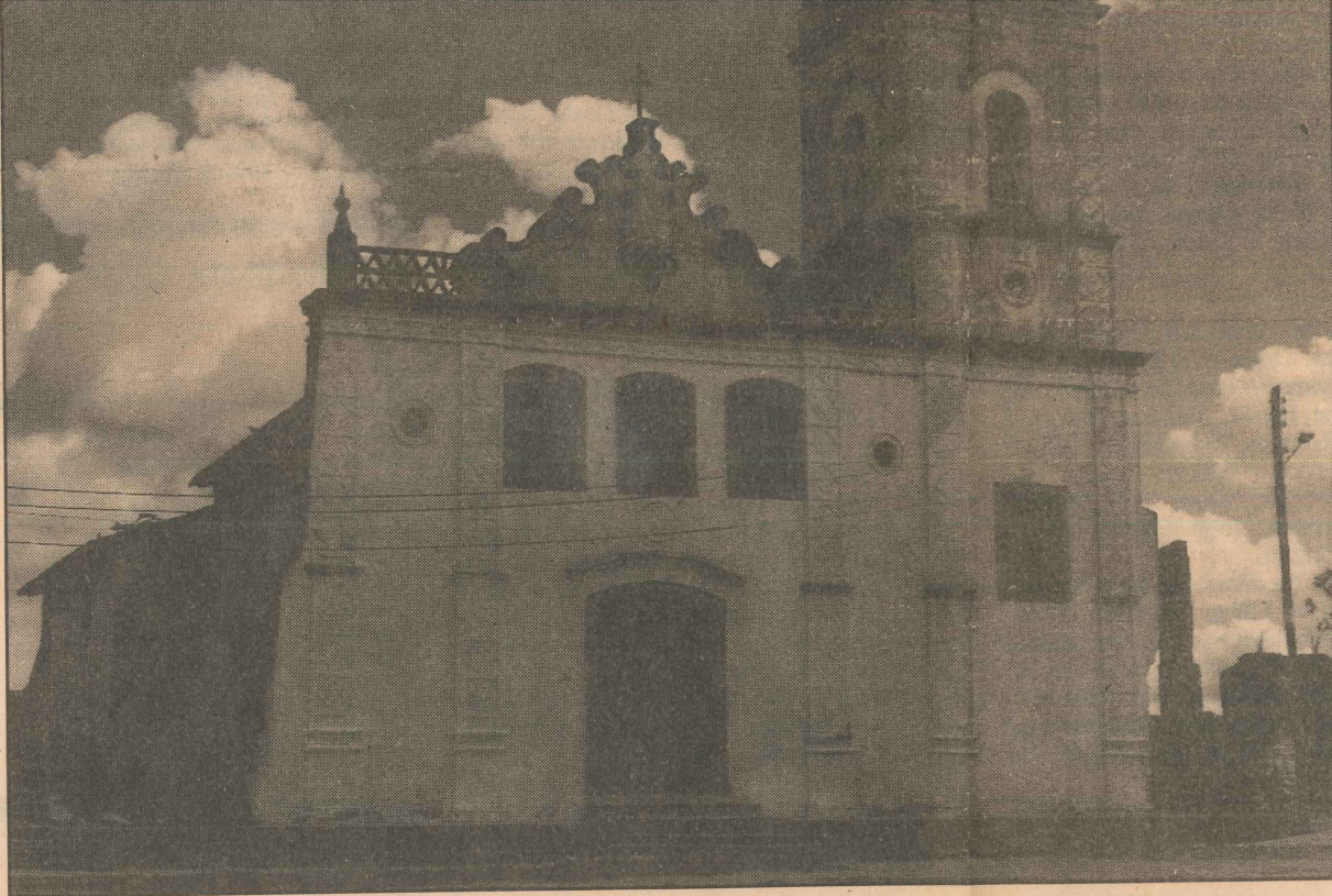
A Igreja de Nossa Senhora da Ajuda, construção jesuítica, já foi restaurada
