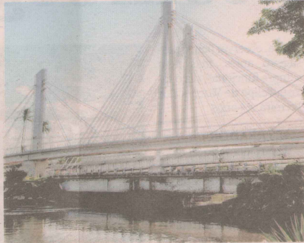
Estrutura da Ponte da Passagem abriga 18 pessoas
