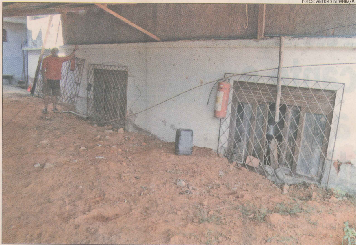
O morador Laci está aterrando área e vai demolir sua casa na rua Belas Artes devido aos alagamentos
