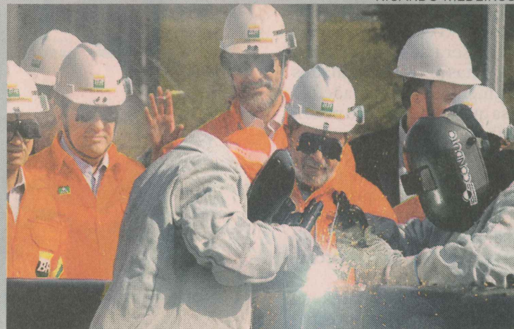
JUNHO DE 2006. Lula fez a soldagem de dois tubos ao inaugurar obras do gasoduto ligando Cabiúnas (RJ) a Vitória (ES), trecho inicial do Gasoduto Sudeste-Nordeste (Gasene)
