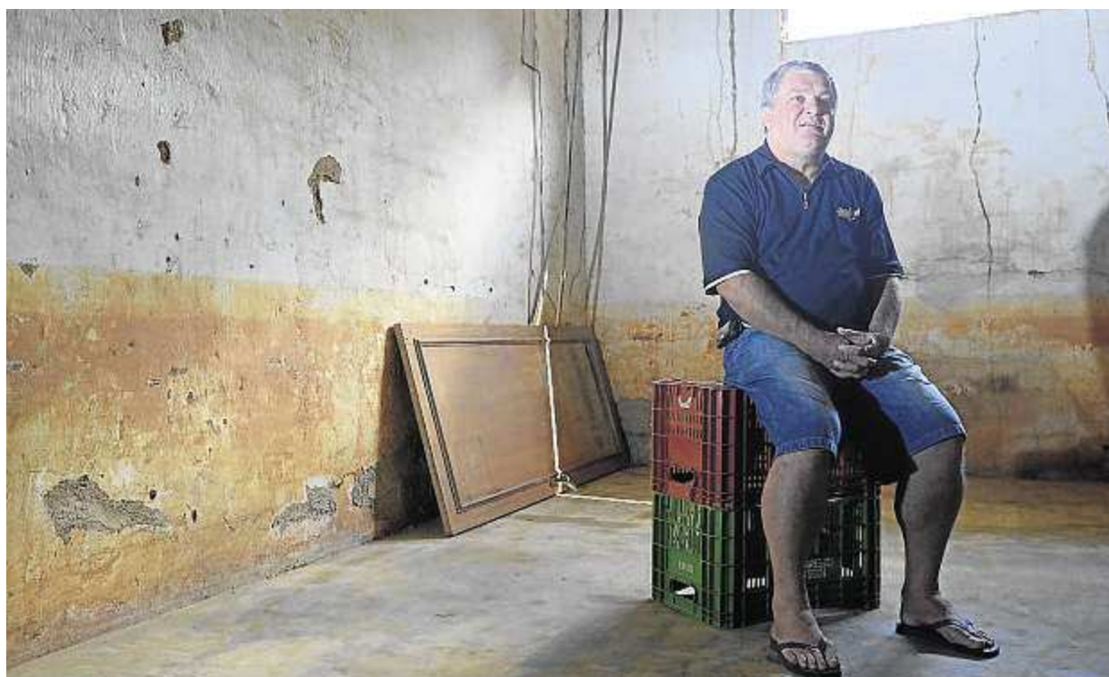
Destruído pela enchente, o supermercado de Celso Pagel ainda não conseguiu repor seu estoque
