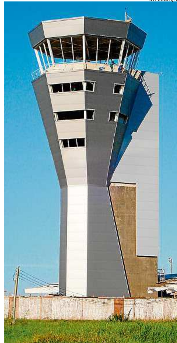
Nova torre de controle até hoje não está funcionando
