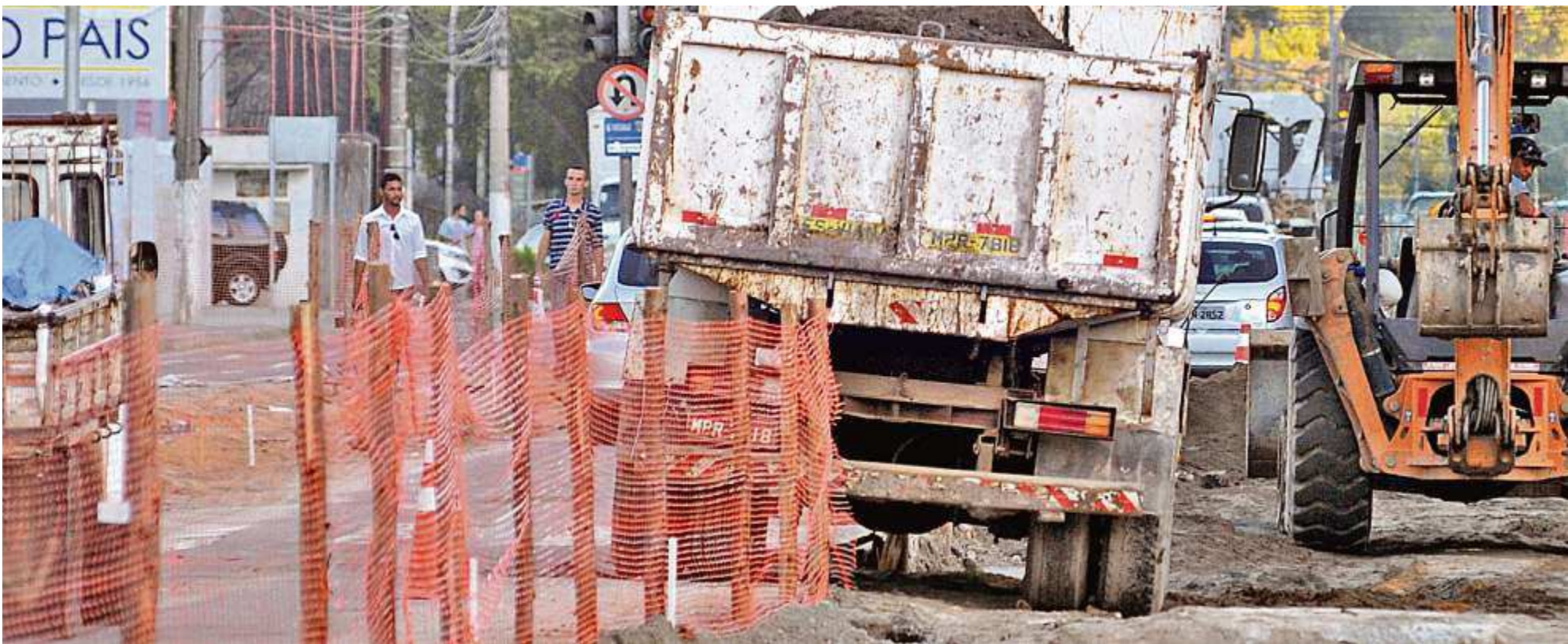
As obras na avenida têm gerado muitos transtornos. A conclusão, prevista inicialmente para o mês que vem, foi adiada para o final do próximo ano, segundo o DER. Est
