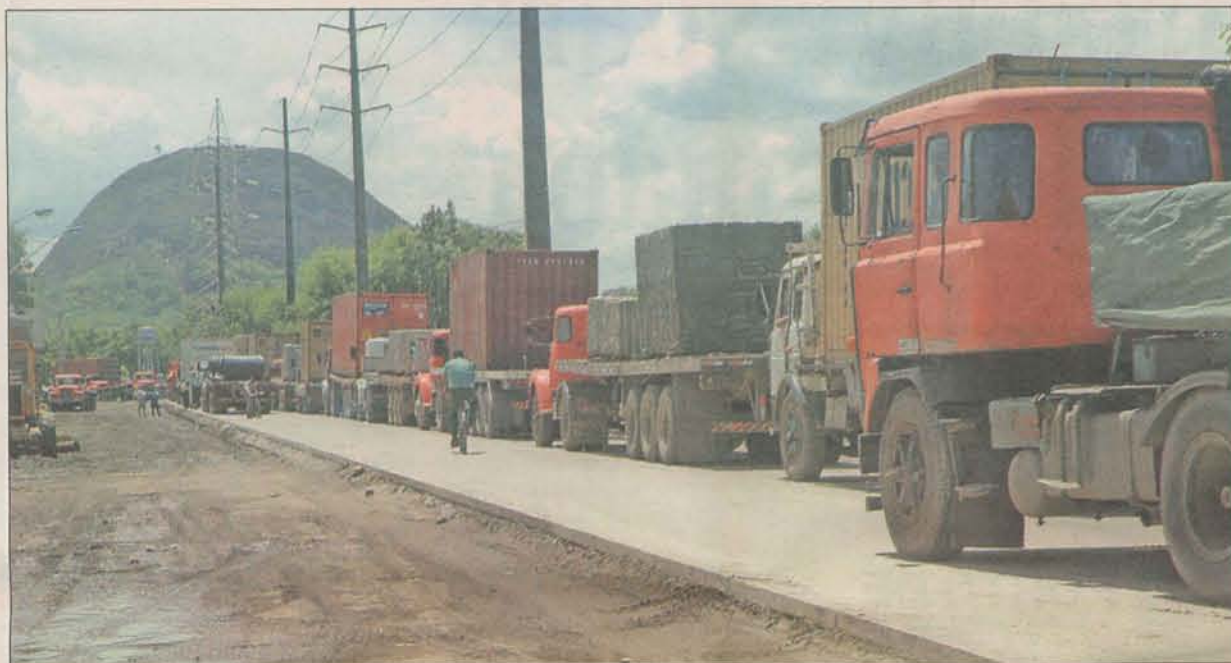
As obras de duplicação e recapeamento já começaram, mas os engarrafamentos persistem
